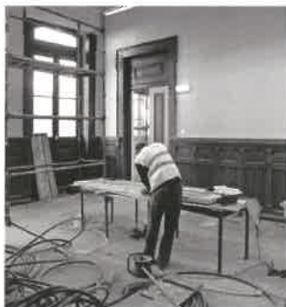
Restauo de carpintarias com substituição mínima recorrendo a madeira antiga de pinho de riga reciclada (Arquivo VMSA Arquitectos, Julho 2009) Restoration of carpentry with minimum substitution resorting to old recycled Riga pine wood. (VMSA Arquitectos Archive, July 2009)
